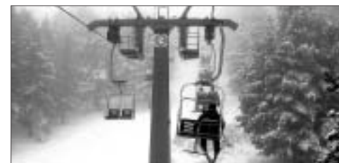
EFFE TELESILLA. Remonte de la estación de esquí de Valdelinares.
